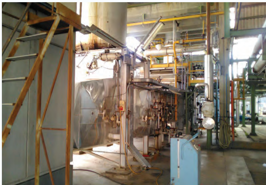
Immagine 1 Canalizzazione fumi esausti e caldaia a recupero Impianto di Cogenerazione Stabilimento di Campoverde di Aprilia.
