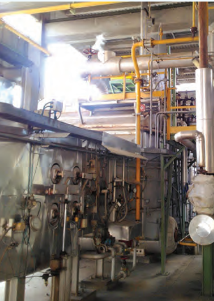
Immagine 1 Canalizzazione fumi esausti e caldaia a recupero Impianto di Cogenerazione Stabilimento di Campoverde di Aprilia.
