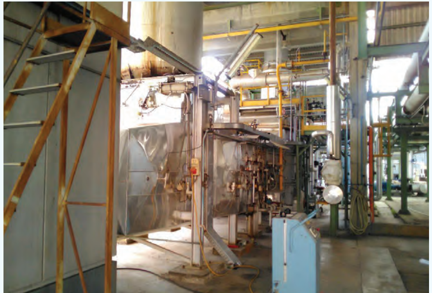
Immagine 1 Canalizzazione fumi esausti e caldaia a recupero Impianto di Cogenerazione Stabilimento di Campoverde di Aprilia.
